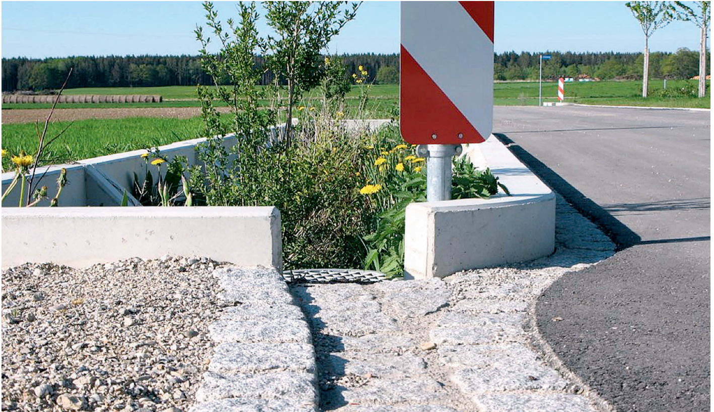
Versickerung des Oberflächenabflusses in vorgefertigten Pflanzbeeten Typ Innodrain. Als Mulden-Rigolen-System konzipiert, als Verkehrsberuhigung einsetzbar, werden sie inklusive Boden und Pflanzen geliefert. Foto: Mall
