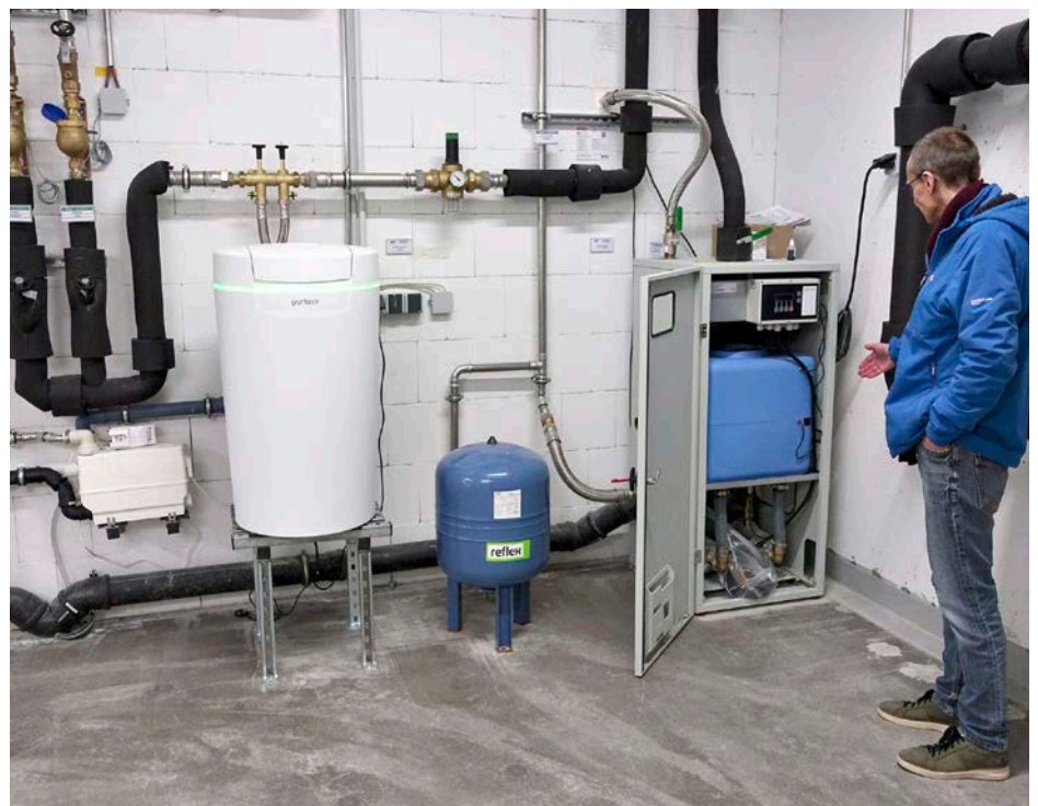
5 Zentrale der Wasserverteilung für die WC-Spülung im Untergeschoss der Carderie. Rechts die Regenzentrale, ein Schaltschrank mit Vorlagebehälter (blau), darunter zwei Kreislumpen. Zusätzlich integriert ist die DIN-gerechte Trinkwasser-Nachspeisung mit „Freiem Auslauf“ in den Vorlagebehälter.
