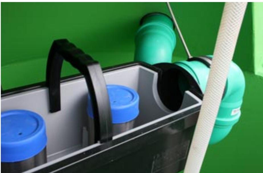
Im Regenspeicher hängt die von oben herausnehmbare Filterwanne zwischen Zulauf (l.) und Überlauf (r.). An der Rückwand die abgedichtete Durchführung für das Stromkabel. Von unten nach oben die Druckleitung von der Pumpe zur Entnahmestelle im Einsatzdeckel. Fotos: Mall
