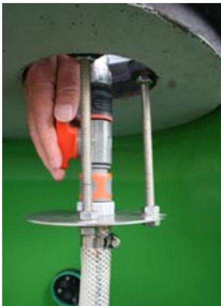
Nach Aufstecken des Gartenschlauchs am Regenspeicher wird von außen manuell das Ventil geöffnet. Damit ist die Unterwassermotor-Pumpe mit integriertem Schaltautomat betriebsbereit, wenn sie beim Einbau des Speichers an das im Erdreich verlegte Stromkabel angeschlossen wurde. Fotos: Mall
