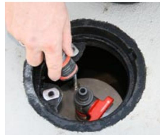
**Regenwassernutzung im Garten mit unterirdisch eingebautem Betonspeicher. Die komplette Entnahmetechnik ist bei Lieferung schon integriert. Mit der Steckverbindung am Gartenschlauch kann das Gegenstück unter dem geöffneten Einsatzdeckel leicht erreicht werden.** Foto: Mall
