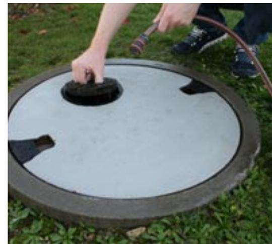
**Regenwassernutzung im Garten mit unterirdisch eingebautem Betonspeicher. Zulauf und Filter, Speicherüberlauf sowie Pumpentechnik werden vom Hersteller bei diesem Typ bereits integriert. Die Entnahme liegt leicht zugänglich unter dem Einsatzdeckel.** Foto: Mall
