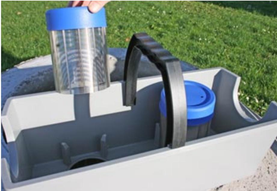
Zur Inspektion und Wartung gehört zweimal im Jahr das Herausnehmen und Leeren des Filterkorbes und das Abbürsten der Edelstahl-Filtereinsätze. Dazu wird die große Speicherabdeckung geöffnet und der an die Rohre gesteckte Filterkorb mit der Hand herausgezogen. Foto: Mall
