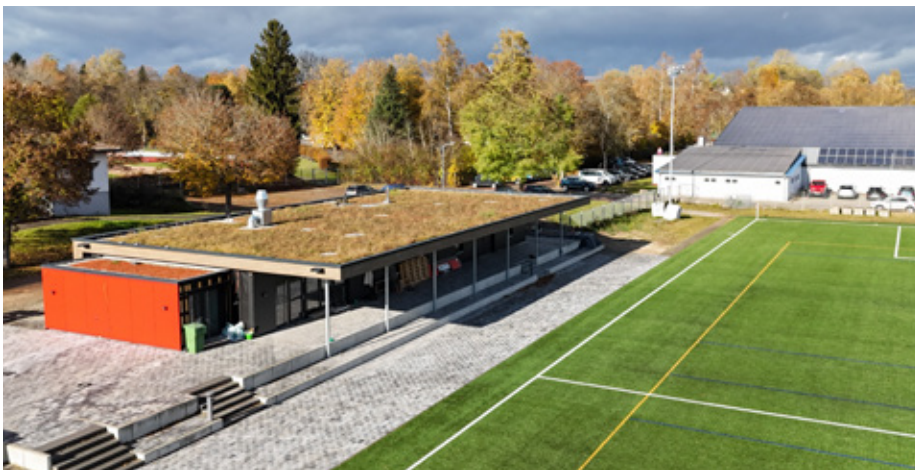
Sportanlage Im Haberfeld, Donaueschingen. Neubau des Vereinsheims SSC links im Bild, mit Retentions-Gründach Sponge City Roof, zum Zeitpunkt der Fertigstellung im November 2023. (Bild: Mall AG)
