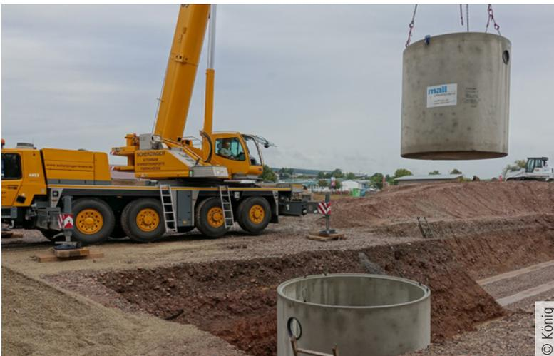
Abb. 2: Unter dem Betriebsgelände werden Betonfertigteile eingebaut, hier zwei Behälter, die zusammen bis zu 20 m<sup>3</sup> Regenwasser zur Nutzung bereithalten. Im Zulauf davor reinigt ein Filterschacht das Wasser, das von den ca. 2000 m<sup>2</sup> Dachfläche stammt.
