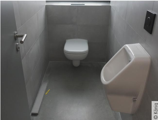
Abb. 6: Eines von mehreren WCs in der Produktionshalle, weitere sind im Verwaltungsgebäude. Zur Spülung wird Regenwasser aus dem unterirdischen Speicher verwendet. Ist dieser leer, wird im Regencentner automatisch mit freiem Auslauf auf Trinkwasser umgestellt.
