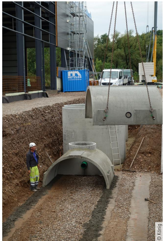
Abb. 3: Montage der Betonfertigteile zu einem unterirdischen Sicktunnel. Im Hintergrund der Substratfilterschacht, der neben mineralölhaltigen Kohlenwasserstoffen auch Feststoffe wie Reifenabrieb und die Schwermetalle Kupfer und Zink aus dem Wasser entfernen kann.
