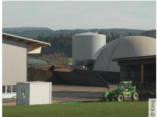
Abb. 7: Biogasanlage Palmhof in Bräunlingen. Von hier aus wird das gesamte Gewerbegebiet Niederwiesen versorgt
