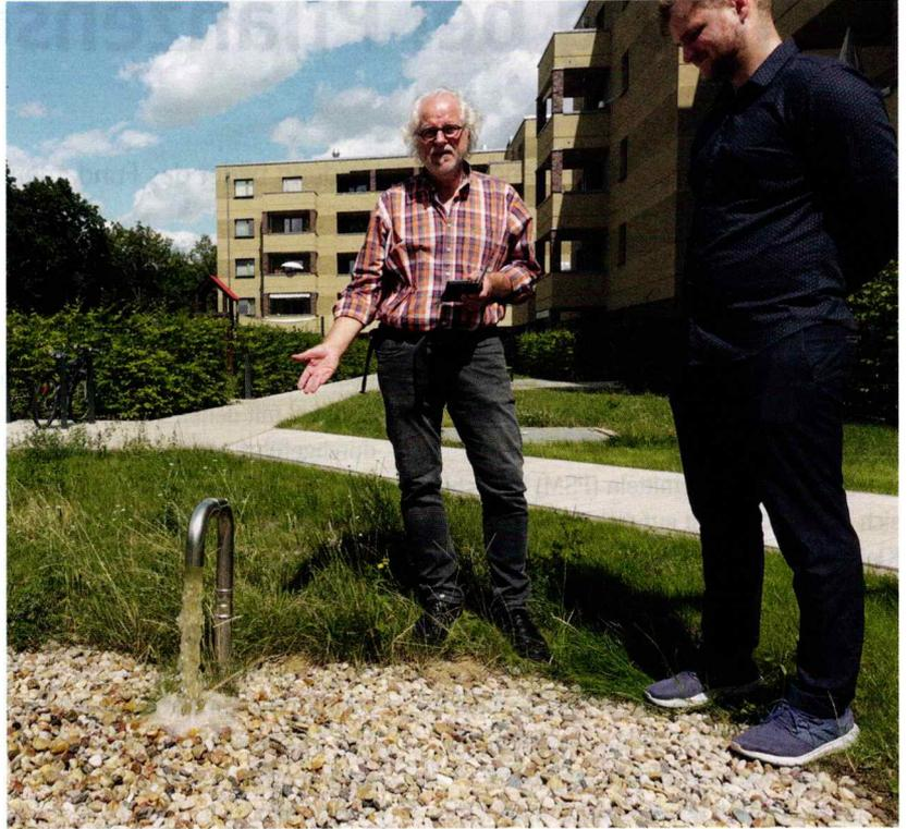
Ist der Regenspeicher voll, wird ein Teil des Wassers automatisch, zur Versickerung in einer Mulde, an die Oberfläche gepumpt. Das schafft Retentionsraum für den nächsten Niederschlag.
