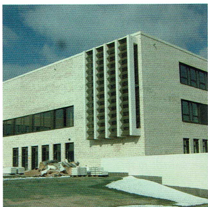
Figure 5: Le centre scolaire à Mössingen, Baden-Württemberg. L'eau de pluie est utilisée comme eau de rinçage pour le sanitaire, et sert également au refroidissement adiabatique de l'air évacué.
