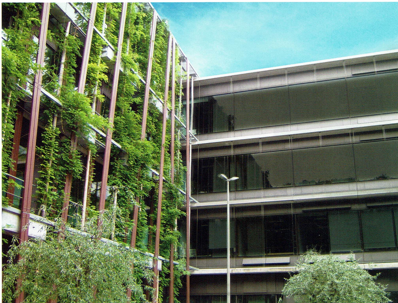
Figure 1 : L'institut de physique de l'université Humboldt de Berlin, campus Aldershof. La végétalisation de la façade sud forme en été un rideau vert étanche. À chaque étage, sont placés des bacs à plantes, avec un système d'irrigation automatique qui est alimenté à partir d'un réservoir d'eau de pluie. Différentes sortes de plantes ont été testées, afin de trouver la variété possédant les meilleures propriétés en termes d'ombrage.
