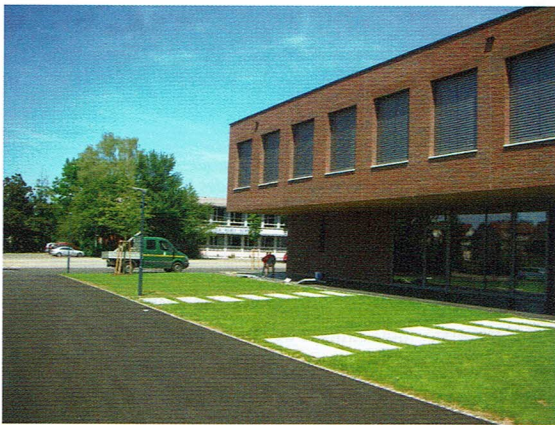
Figure 8: Le gymnase Riedberg à Francfort. Le nouveau bâtiment pouvant abriter 1.350 élèves a été achevé en 2013.
