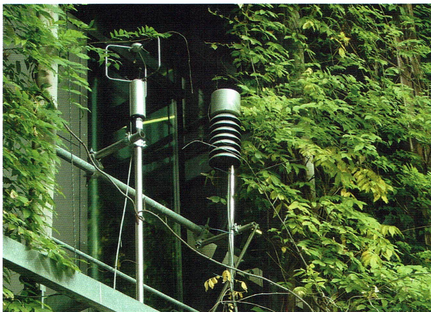
Figure 3 : Station de mesure du fonctionnement du rafraîchissement passif par la toiture verte, ainsi qu'un bac à plantes à irrigation automatique par eau de pluie et un trop-plein.
