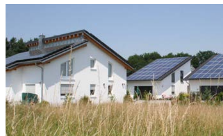
Die Bauherren der Plusenergiesiedlung Vordere Viehweide II verpflichteten sich, Solarmodule auf das Dach zu setzen. (Bild: HFT Stuttgart/Pietsch)
