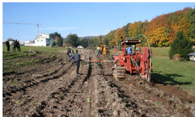
Einpflügen eines Kollektorfeldes im Herbst 2012. Im Hintergrund Häuser der Plusenergiesiedlung Vordere Viehweide II. (Bild: HFT Stuttgart/Pietsch)
