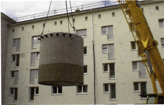
Bild 3 Einer der beiden Pufferspeicher beim Versetzen
