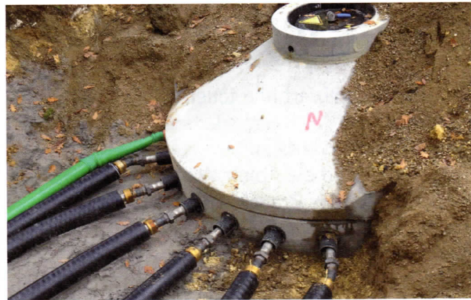
Bild 4 Pufferspeicher ThermoSol mit werkseitig eingebauten Edelstahlrohren für den Anschluss der unterirdischen Verbindungsleitungen zum Gebäude. Links außen befindet sich ein Leerrohranschluss für die Elektroleitungen der Temperaturfühler
