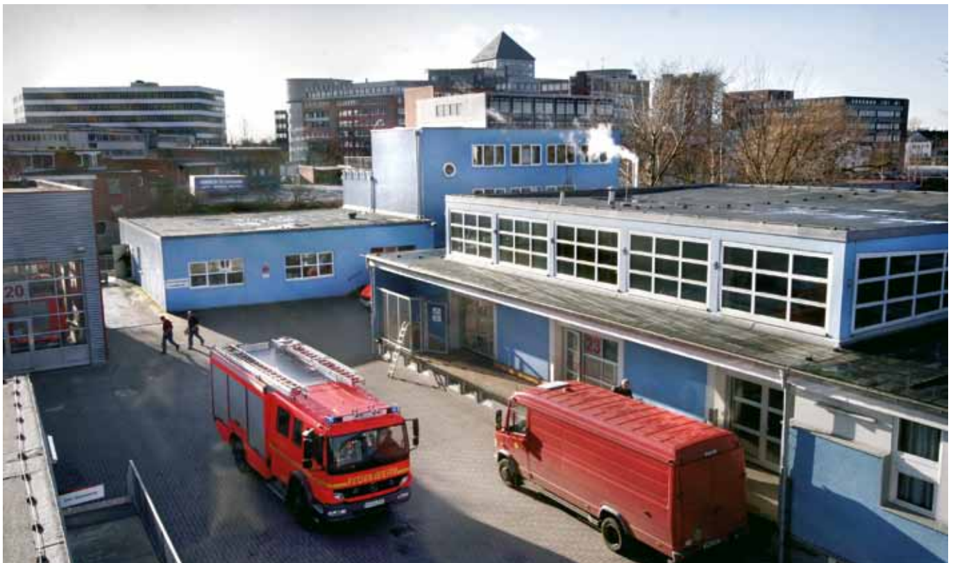
Im Technikzentrum der Hamburger Feuerwehr steht eine Wirbelbett-Anlage. 40 Mitarbeitende duschen hier täglich, das Betriebswasser wird für die Schlauchreinigung verwendet. Die Einsparung liegen bei ca. 500 m 3 Wasser pro Jahr. Foto Pontos
