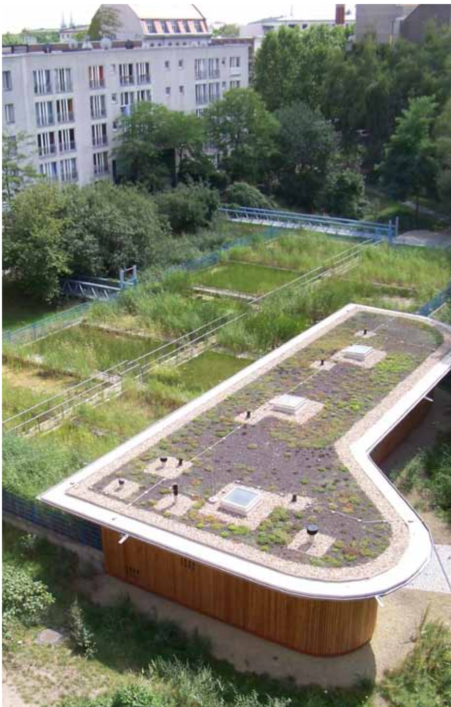
«Gartenhaus» und Demonstrationszentrum für die Wirbelbett-Anlage, Block 6 Berlin. 10 m 3 Betriebswasser werden pro Tag für Toilettenspülung und Gartenbewässerung genutzt.
