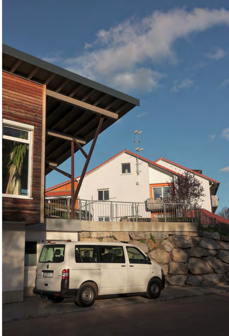
◀ Bild 1 • Michael-Gemeinschaft e. V., eine Jugendhilfeeinrichtung im Landkreis Lörrach, 2019 von Öl auf Holzpellets umgestellt. Hinten das Bestandsgebäude, links der Neubau mit Saal. Im Hang hinter der Natursteinmauer ist das Pelletlager integriert. Bild: König
