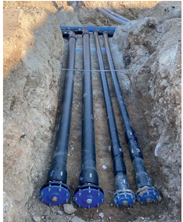
Bild 2: Kaltes Nahwärmenetz, Sekundärkreislauf zwischen Wärmetauscher und Hausanschlüssen. Rohrleitungen links in das Gebiet Weiermatten, rechts in das Gebiet neue Ortsmitte. Ungedämmte Leitungen für Wasser mit 12-16 °C im Vorlauf. © Energiedienst/Junkov
