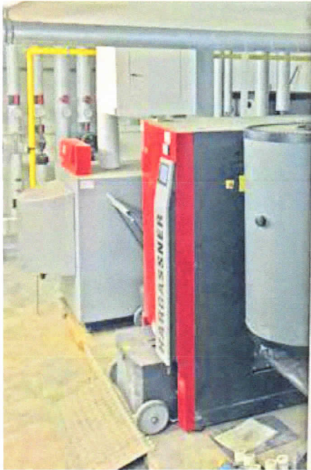
Heizraum im Untergeschoss des Hauses Grabenäckerstr. 15. Holzpellet-Grundlastkessel und Gas-Spitzenlastkessel.
