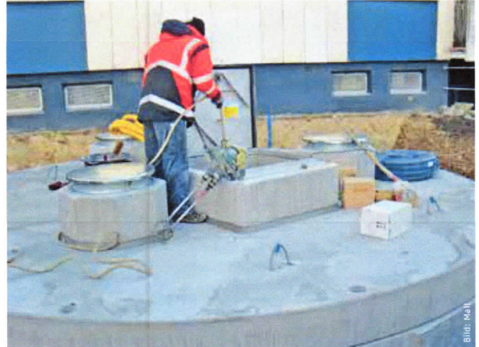
Pelletspeicher bei der Endmontage. Zu sehen sind die drei Befüllöffnungen für den Brennstoff.
