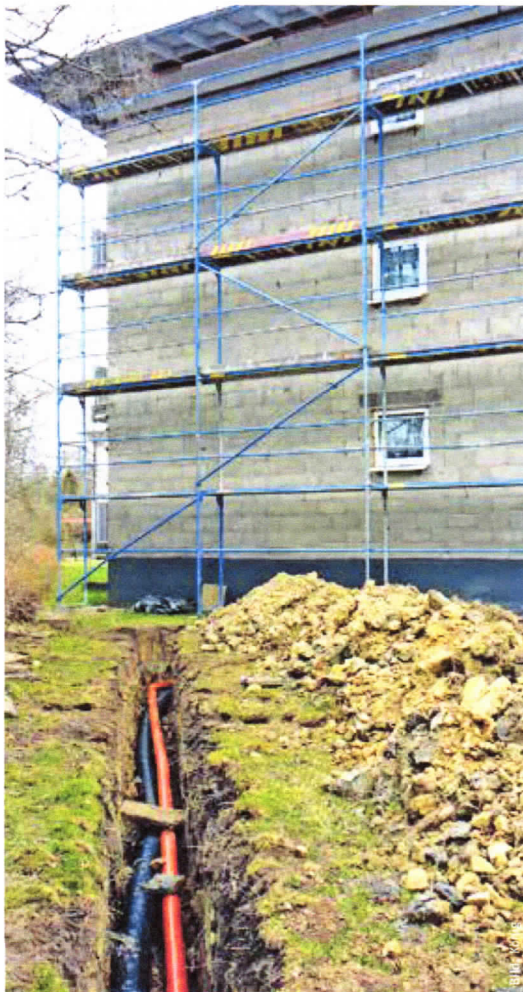
Im Rahmen der Sanierung wurde auch das Nahwärmenetz komplett saniert.
