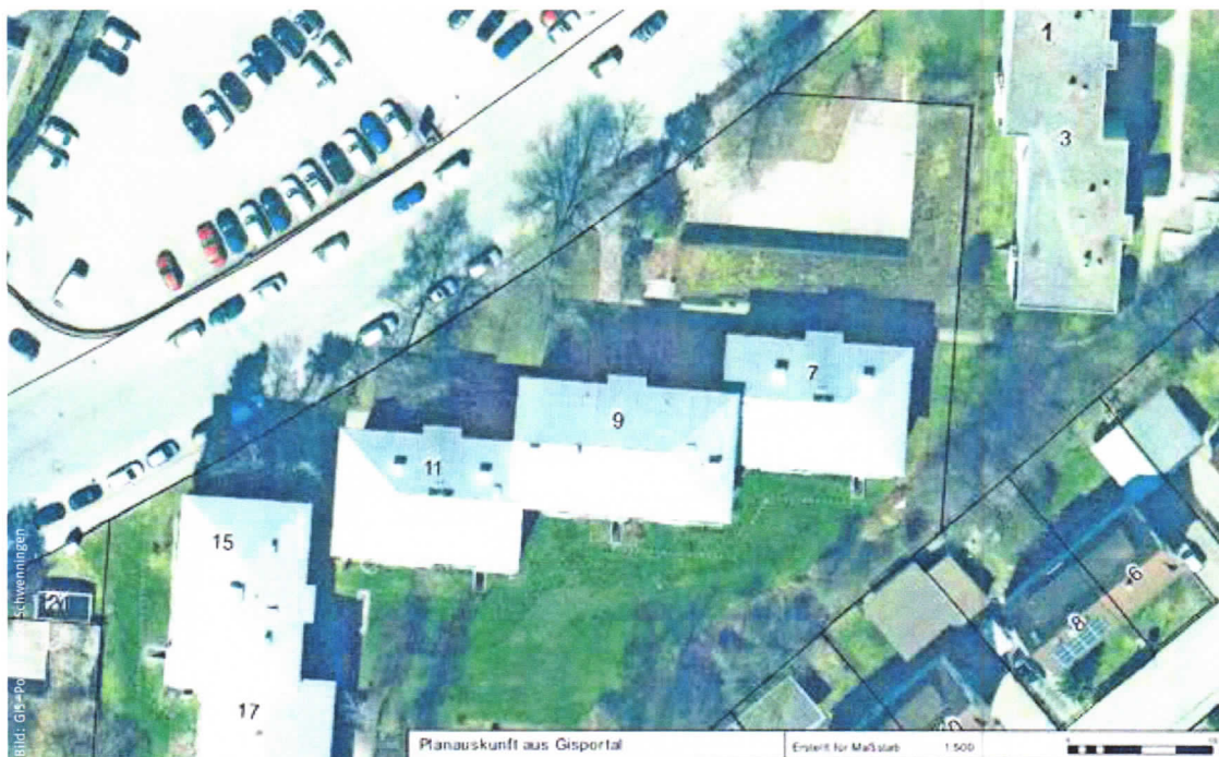
Mehrgeschossige Wohngebäude in Schwenningen. Luftbild der 7 Gebäude, die im Jahr 1969 mit Nahwärmenetz erstellt wurden. Die Heizzentrale befindet sich im Keller von Haus 15.
