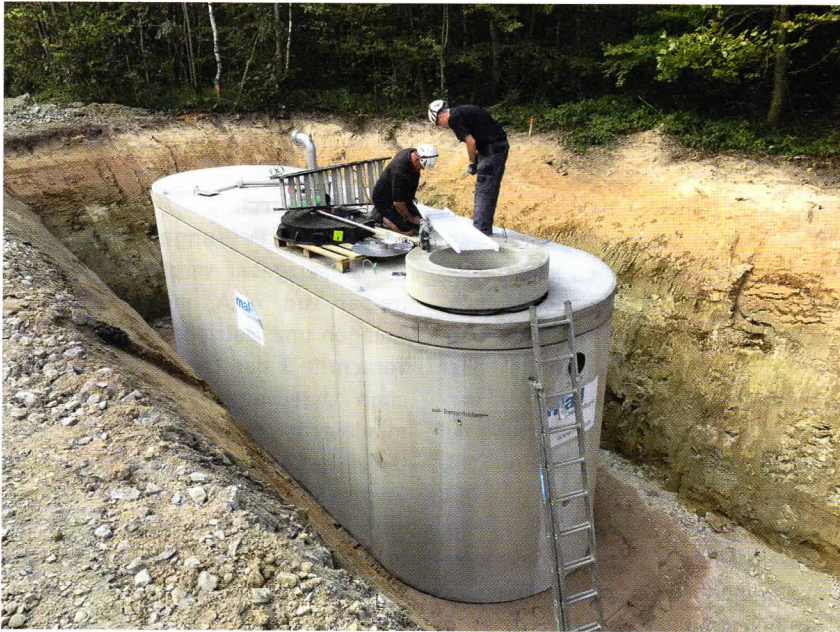
Der Ovalbehälter mit 30 m 3 Fassungsvermögen kann mit seinen Abmessungen von 8 m Länge, 2,48 m Breite und 2,85 m Höhe ohne Sondergenehmigung vom Hersteller zur Baustelle gefahren werden
